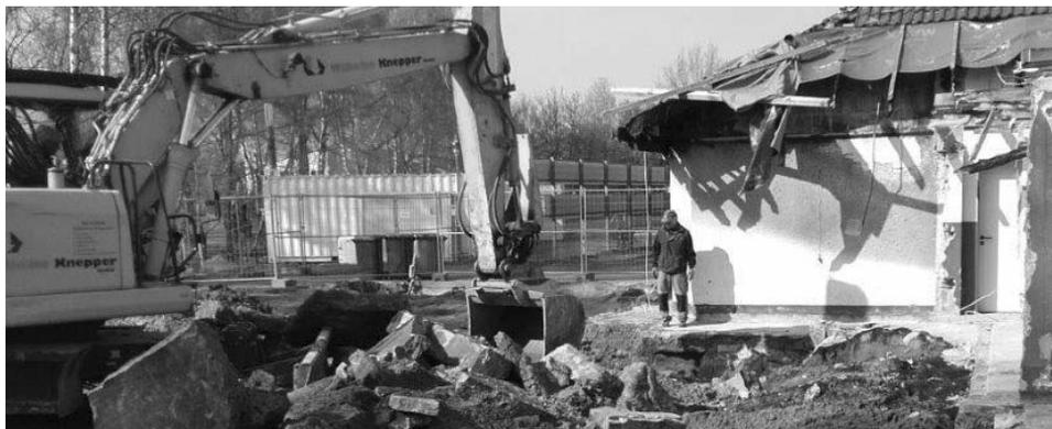
*Mit schwerem Gerät entfernte die Firma Knepper die Bodenplatte der beiden Garagen und die Fundamente.*
